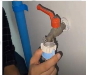
ต่อสายน้ำเข้ากับก๊อกน้ำ
