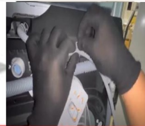
เชื่อมต่อท่อน้ำทิ้งสำหรับเครื่องอบและเครื่องซัก
