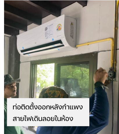
ก่อนติดตั้งออกขวาในห้อง สายไฟเดินซ่อนในราง
