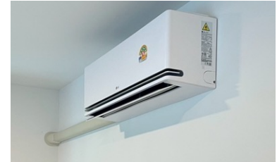
ก่อนติดตั้งออกซ้ายในห้อง สายไฟเดินซ่อนในราง
